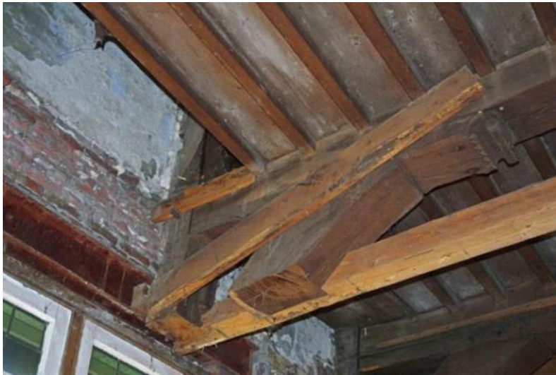
Een monumentaal pand na ontmanteling. Onderzoek naar de constructieve veiligheid in het kader van het herstel.
