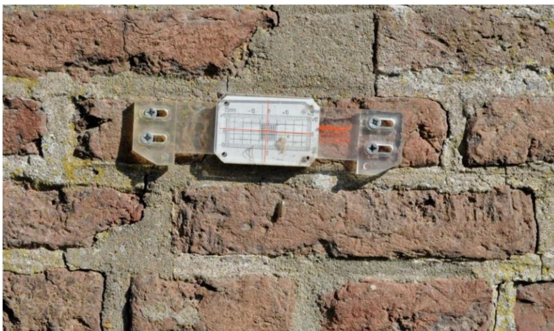
Waterpassing voor monitoring ongelijkmatige zetting – rotatie
